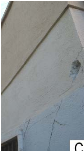
Fessurazione nodo d'angolo
